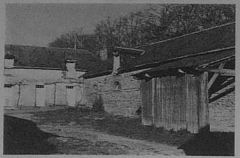
L'ancienne ferme de la Touche Ablin, bientôt en maison des associations.
