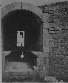
Fenêtre et chambre de veille de la tour sud-est.
