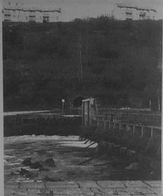
L'écluse du Gorle
