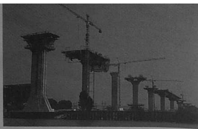
Le chantier du futur pont de Cheviré
