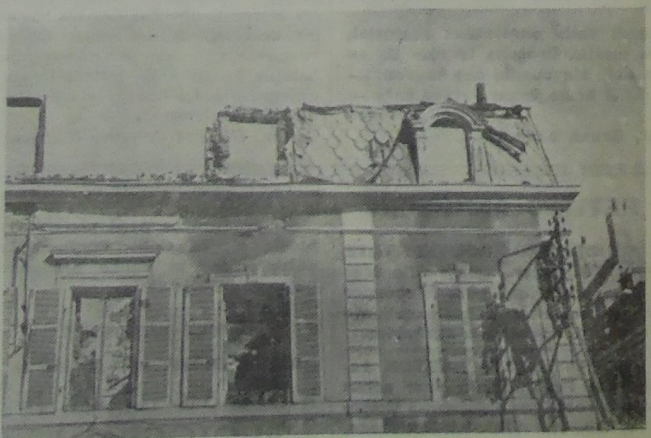
Rue Jules-Le-Grand, le toit de cette maison et les appartements sont entièrement détruits.
