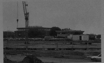
Un nouveau parking en construction à Gavy.
