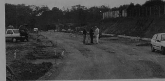
La voie de liaison actuellement en cours de réalisation.
