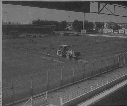
Le drainage de la pelouse de Fred Aubert devrait donner des ailes aux "griffons".
