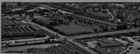
Les futurs locaux que le groupe Mazureau implantera sur le site de l'ancien abattoir, face à Promodes, dont la démolition s'achève.
