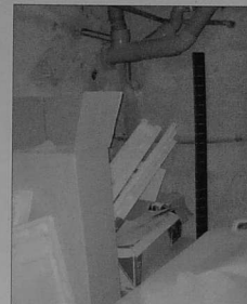
Les encombrants entreposés dans les locaux poubelles des collectifs, une mauvaise habitude.
