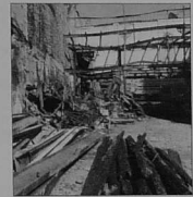
Le site a été débarrassé dans le courant du mois d'avril.
