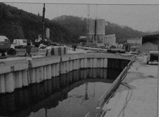
Le futur site de réparation pour les bateaux de pêche.
