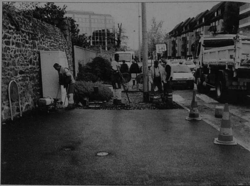
Les agents de la voirie remplacent les pavés par un revêtement lisse rue Abbé Garnier, près du centre des impôts.
