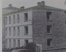
Le bâtiment des personnes âgées en cours de rénovation
