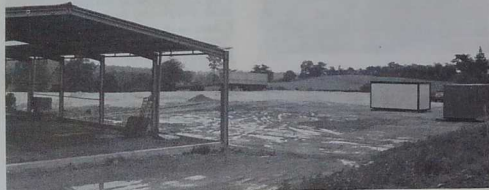
Zone d'activités : aménagement d'une plate-forme pour la société de transports
