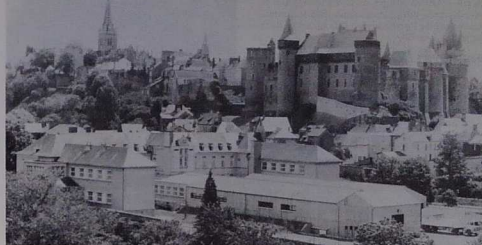
Au premier plan, les locaux
