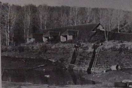
Forges des Salles (Ploemel, C. du N.). Bâtiment de la Forge neuve devant sa cage de retenue, un appareil au premier plan les 2 usines motrices et au second plan les 3 ouvertures par lesquelles étaient stockées les matières premières (début XIX e ).
