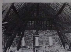
Forges des Salles (Ploemel, C. du N.). Bâtiment de la Forge neuve devant sa cage de retenue, un appareil au premier plan les 2 usines motrices et au second plan les 3 ouvertures par lesquelles étaient stockées les matières premières (début XIX e ).
