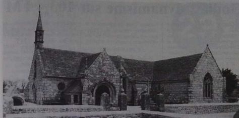
Un riche patrimoine architectural (ph. M. Le Tollec)
