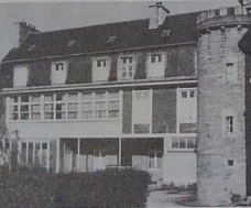
"Ma Maison" avant la démolition
