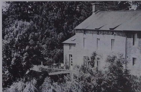
Un bâti traditionnel à préserver
