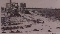
Découverte d'une nappe d'eau pure dans du grès, à 105 m de profondeur
