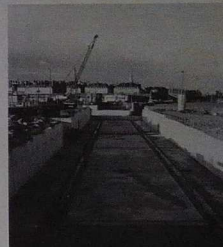
Le pont sur les écluses
