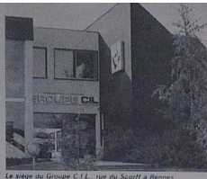
Le siège du Groupe C.I.L. rue du Scoffré à Rennes
