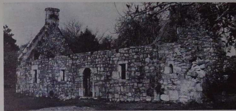
La ferme du Créac'h en cours de restauration
