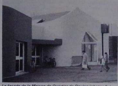
La façade de la Maison de Quartier de Doulon (photos Frédéric Le Stanc)
