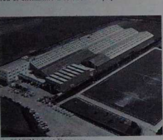
La SEAGEM à Saint-Thégonnec.
