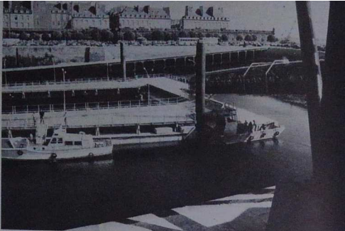
Le nouvel embarcadere et le tunnel que les passagers doivent utiliser pour sortir ou aller dans la gare maritime.
