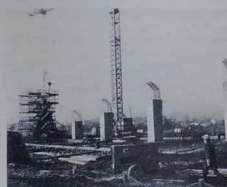
Chantier du Stade de la Beaujoire : les premiers pylônes de béton (Photothèque Ville de Nantes).
