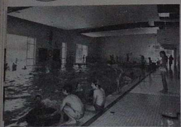
La piscine climatisée et couverte du Parc des Sports
