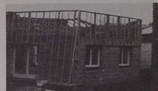
Mise en place de la charpente
