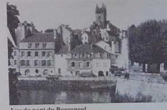
Vue du pont du Bourgneuf
