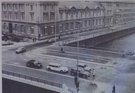
Le nouveau pont Pasteur
