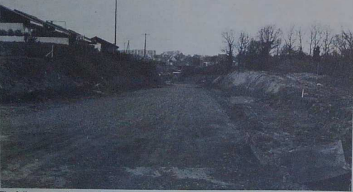
Bientôt l'ouverture de l'avenue de Bretagne
