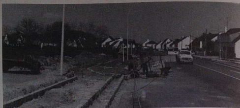
Travaux avenue de la Cholère pour aménager des pistes cyclables.
