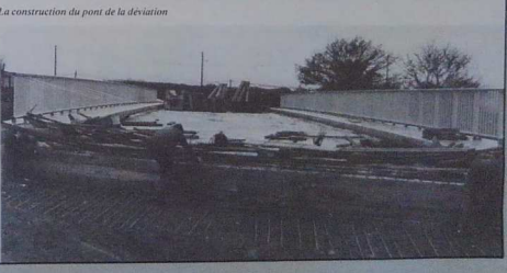
La construction du pont de la déviation
