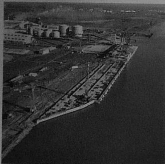
TRAVAUX DE DOUBLEMENT DU QUAI DE MONTOIR
