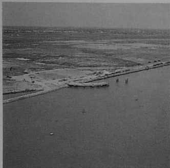
ZONE REMBLAYEE DE MONTOIR
