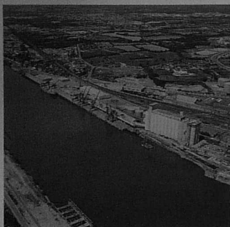
LES TRAVAUX DE DOUBLEMENT DU SILO DE ROCHE-MAURICE
