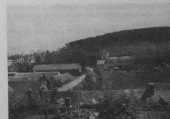
Vue d'ensemble de l'usine
