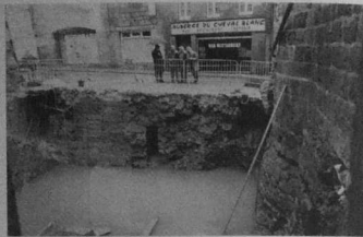
Emplacement actuel du Crédit Mutuel de Bretagne. (Le « dallot » d'écoulement des eaux de l'ex fontaine Notre-Dame-d'entre-les-Portes est parfaitement visible.)
