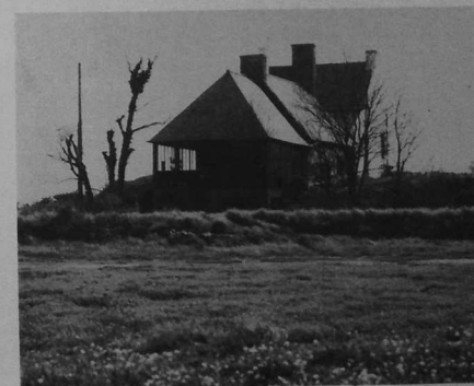
L'atelier transparent, construit en 1959 par l'entreprise Dagon de Plouguel: les matériaux étaient déposés par bateau. Sandy, qui payait en liquide, venait, selon son expression, «apporter un peu de munitions» au fur et à mesure de l'avancement du chantier.
