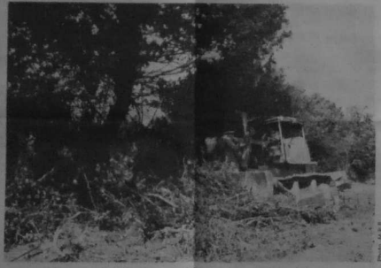
Construction d'un barrage et des biefs pour la circulation de l'eau.
