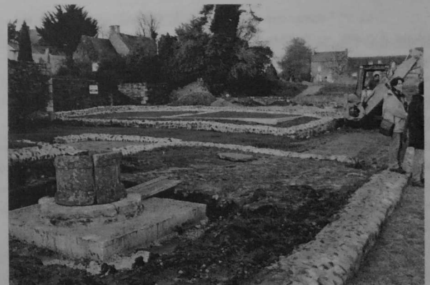
Restauration coté sud du quartier. Installation du puits dans la cour de la domus à la cave et à la salle à hypocauste
