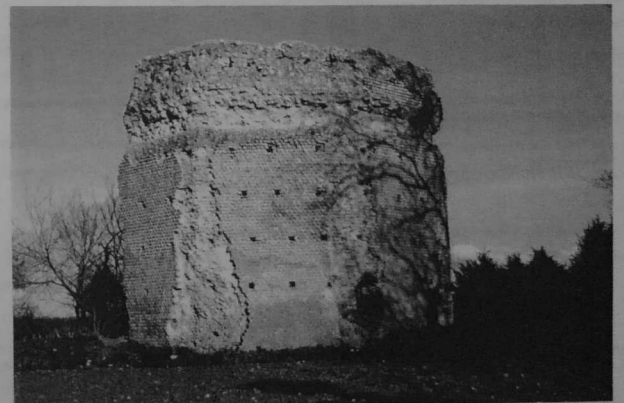
2) - La cella avant la campagne de restauration de 1993. On distingue, vers le haut du mur, une bande dépourvue de pierres de parement qui correspond à l'empreinte, en négatif de l'ancrage de la toiture de la galerie (cliché S. Guidon, 1986)
