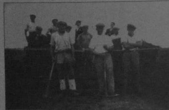
Les ouvriers aménagent le terrain d'aviation.
