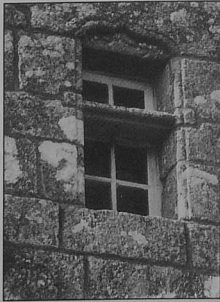
Fenêtre de la lucarne à traverse et arc en accolade
