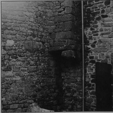
LATRINES en encorbellement
