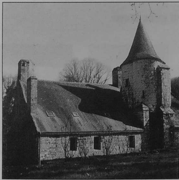
COAT-COURAVAL : tour circulaire en façade arrière. A noter : la tour est ici épaulée par un puissant contrefort à double ressaut.
