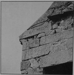
KERINGAMP : chevronnière et pierre de crossette
