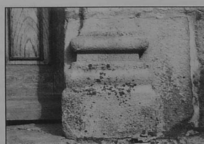
Détail des moulurations de la BASE DU PILASTRE droit
