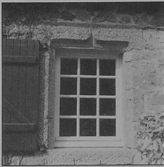
Rez-de-chaussée : fenêtres à arcs en accolade
