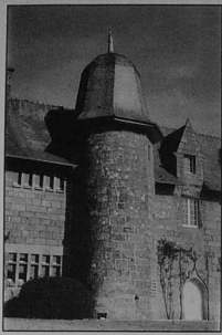
CAMPOSTAL : tour octogonale en façade avant
