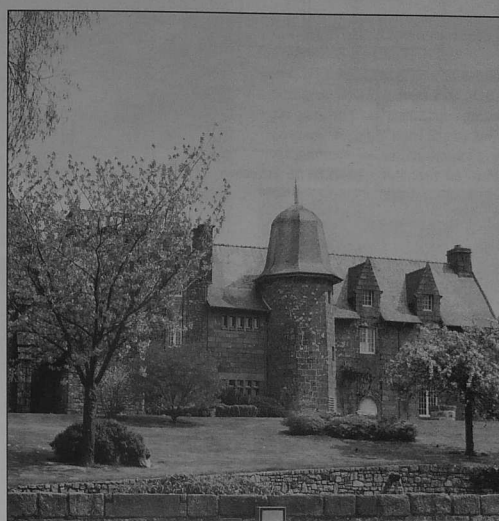
Manoir de CAMPOSTAL : façade principale (matériau : le granit)
