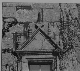
CAMPOSTAL : fronton surmontant la petite fenêtre de la façade principale.
