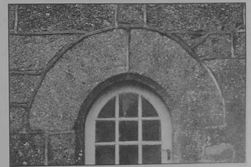
Manoir de KERIOU - Arc plein cintre composé de deux claveaux
