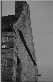
KERINGAMP : détail du rampant
