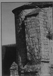
CONTREFORT de la tour
