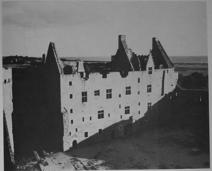
Vue générale, en façade sur la cour, du corps de logis ouest, avant travaux.
