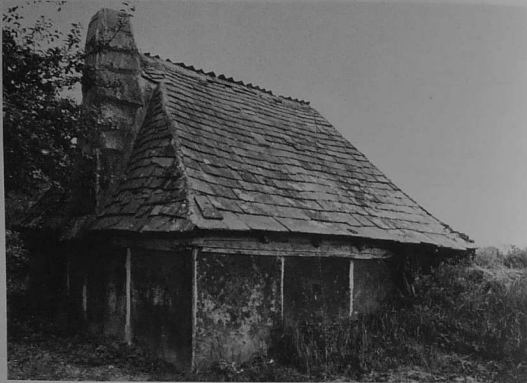
Laniscat (Côtes-du-Nord) : maison en orthostats de schiste, habitat actuellement en voie de disparition.
