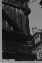
Dinan - Place de l'Apport. Mutilation d'une façade-vitrine. Un galandage placé au nu de la colonne ferme le jour de la baie, mettant à l'extérieur l'élément poteau, jadis intérieur. Il s'agit ici d'un poteau cornier recevant une poutre placée dans la bissectrice des deux faces.
