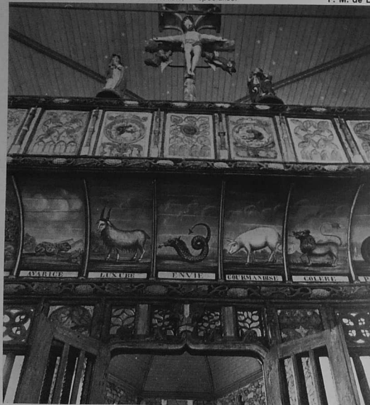
Plelauff (Côtes-du-Nord). Chapelle Notre-Dame-de-la-Croix. Le jubé après restauration et remise en place. On aperçoit, à travers les portes, le chœur, dont les enduits ont été hélas piochés...
