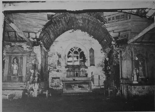
La Chapelle-Neuve - L'intérieur délabré de la chapelle de Locmaria (en cours de restauration). (Cliché Arch. dép. du Morbihan.)
