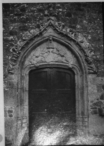
La porte armoriée au sud de l'église
