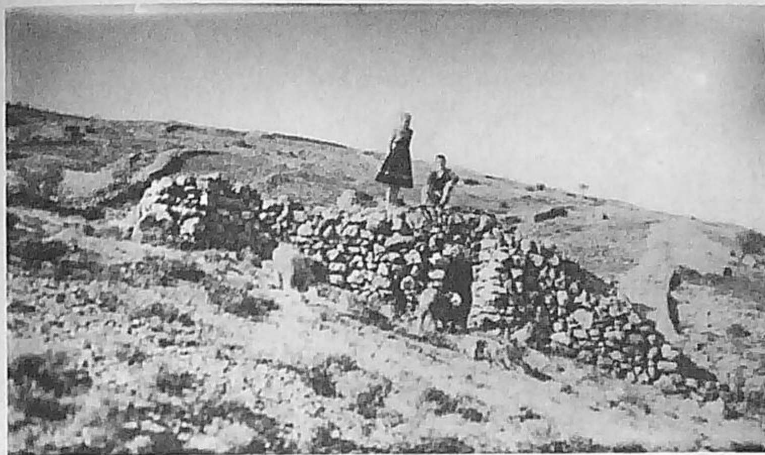
Photo 5 - Fitou (Capitelle), au fond des enceintes de parcs.
