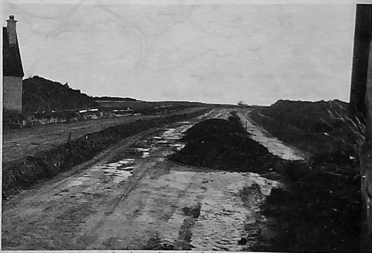
Une infrastructure au service du tourisme : les bulldozers en action à Kerjouanno, dans la presqu'île de Rhuys, en 1973.
