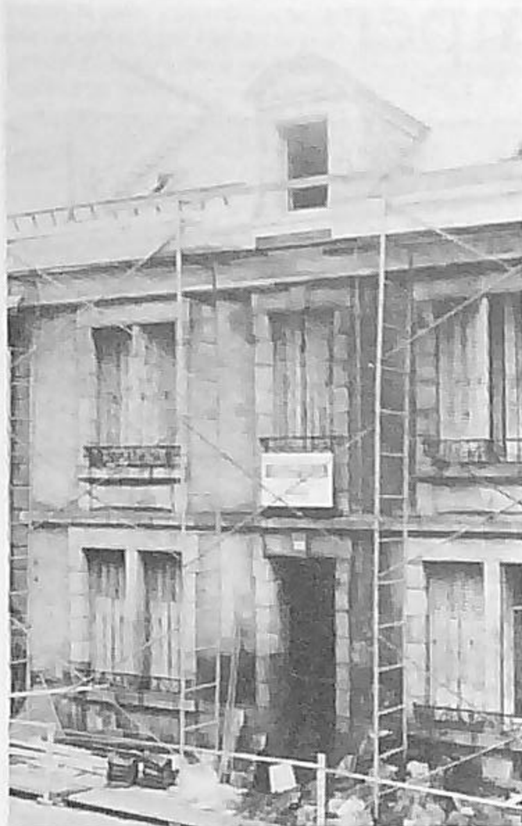
Amélioration de l'Habitat Ancien
