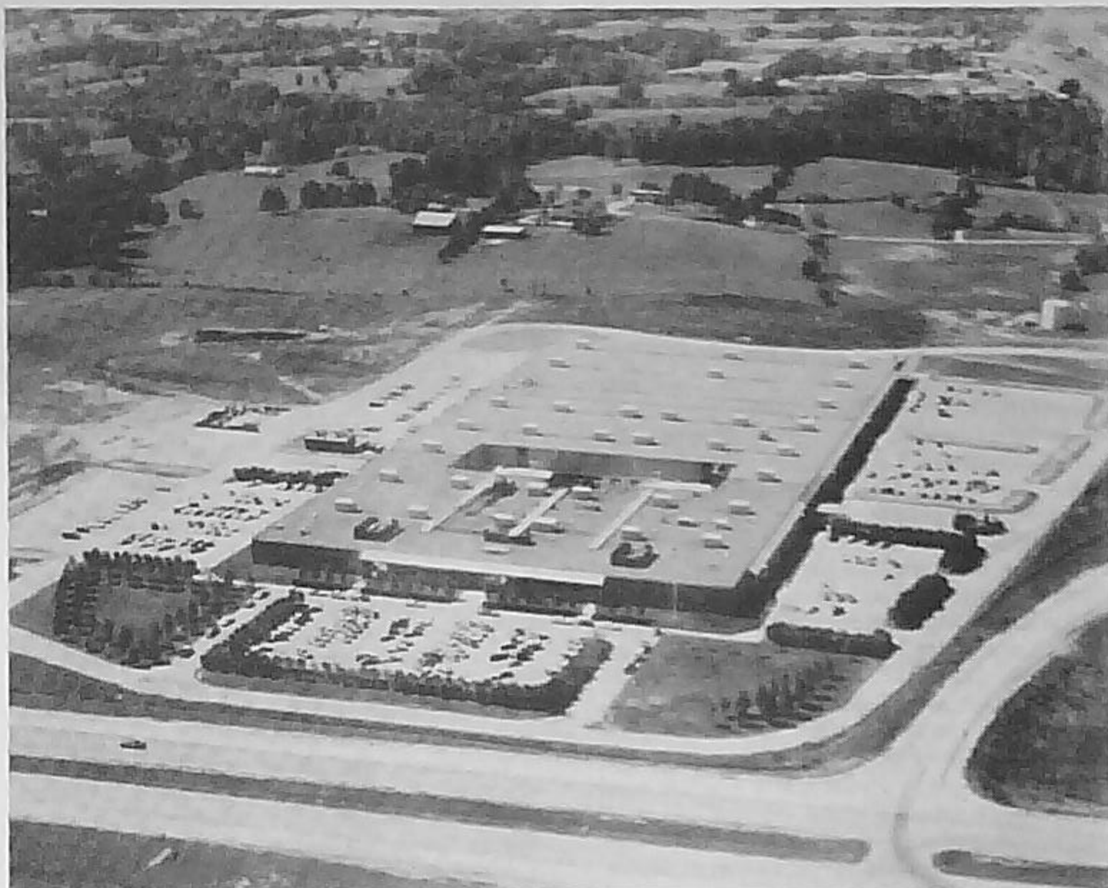
Actuellement tous les produits Fleetguard sont fabriqués dans une usine de 40 000 m 2 couverts, à Cookeville, Tennessee.
