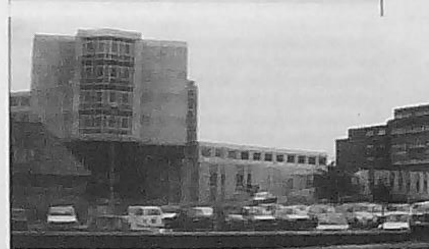
Le nouvel hôpital de Saint-Malo
