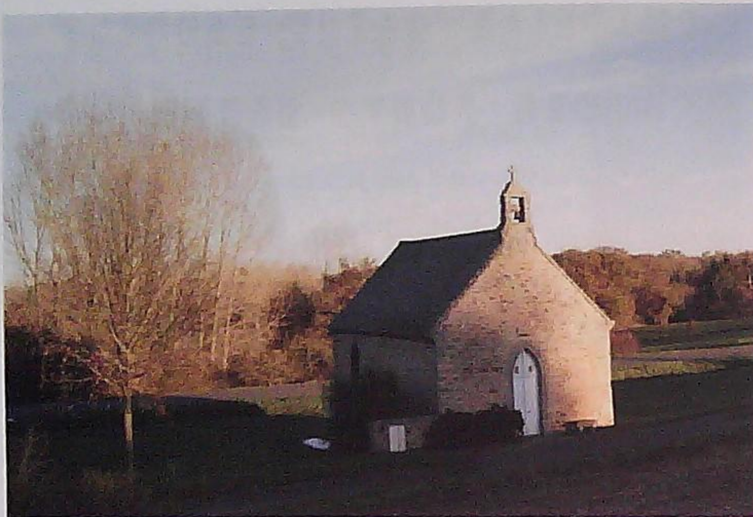
La chapelle sur son site
