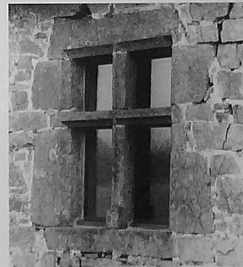
Fenêtre à meneau (vertical) et croisillon (traverse).
