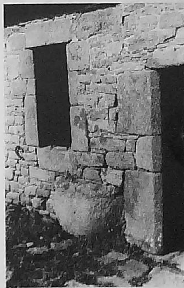
Partie postérieure d'un saloir encastree dans le mur.
