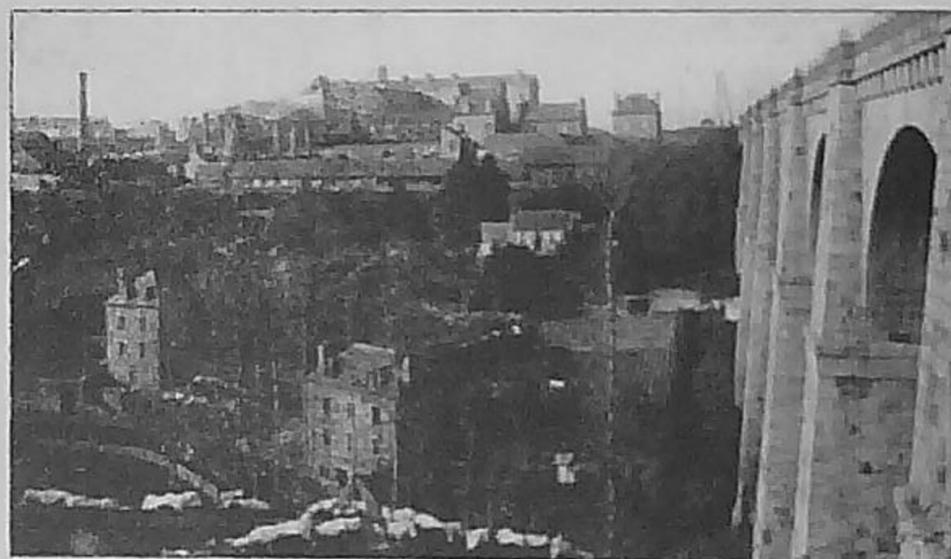
Le viaduc est réalisé en pierres de taille de granit, extraites dans une carrière située à proximité de l'emplacement du viaduc.
