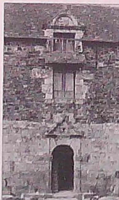
Le Penquer. Appareil mixte de granite et schiste
