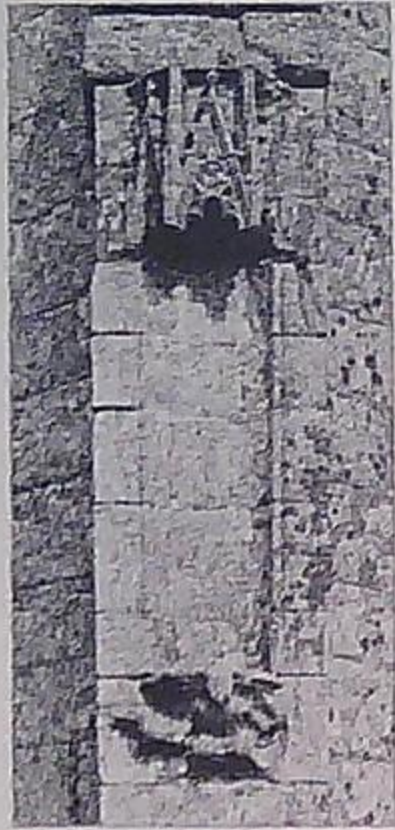
Chapelle Saint-Eloi Contrefort à niche.
