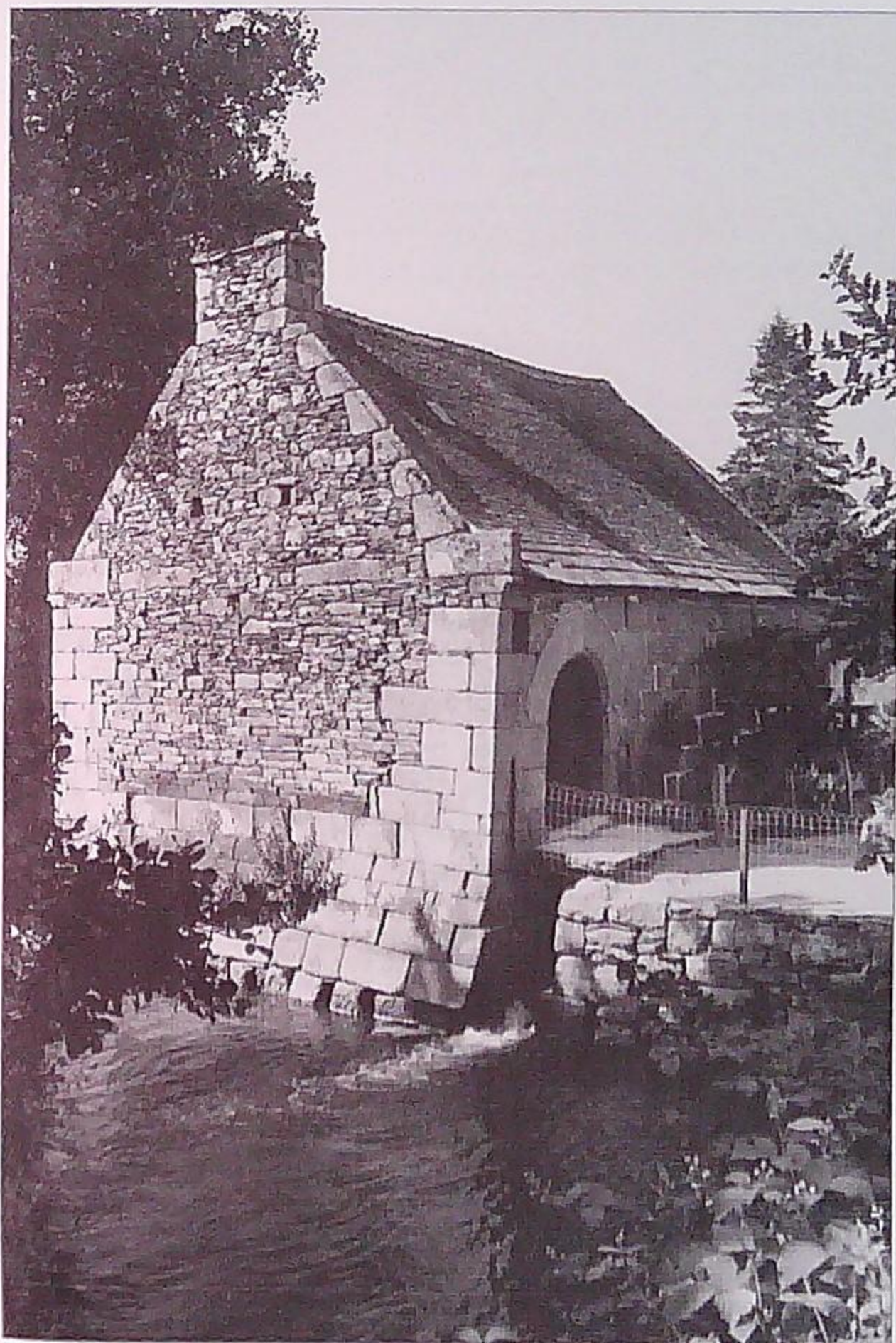
Kermarc'h, Moulin. XVIIe s. Vue de l'aval
