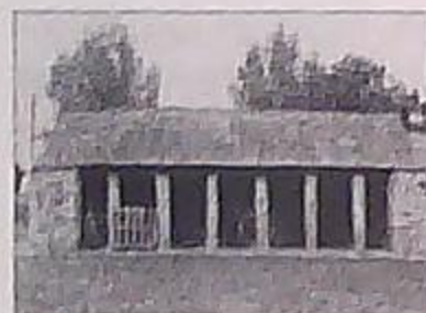
Restmerien. Hangar à piliers.
