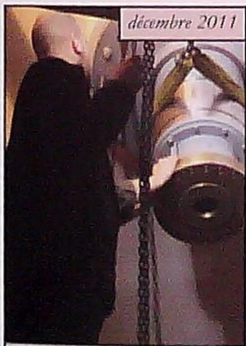
Installation des moteurs
