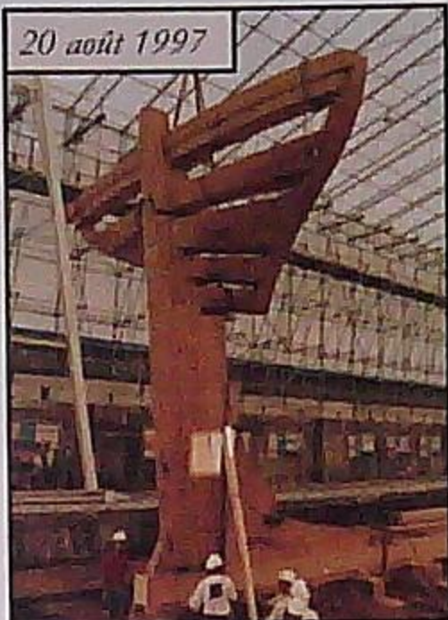
Pose de l'arcasse
