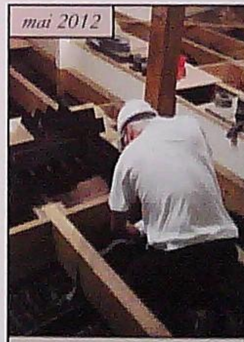
Installation du lest
