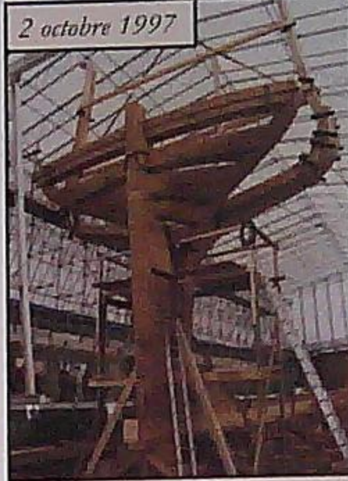
Pose du premier couple
