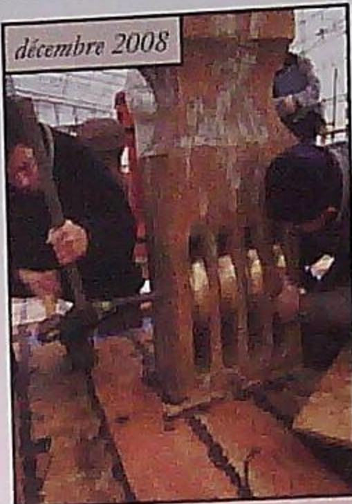
Pose des réas
