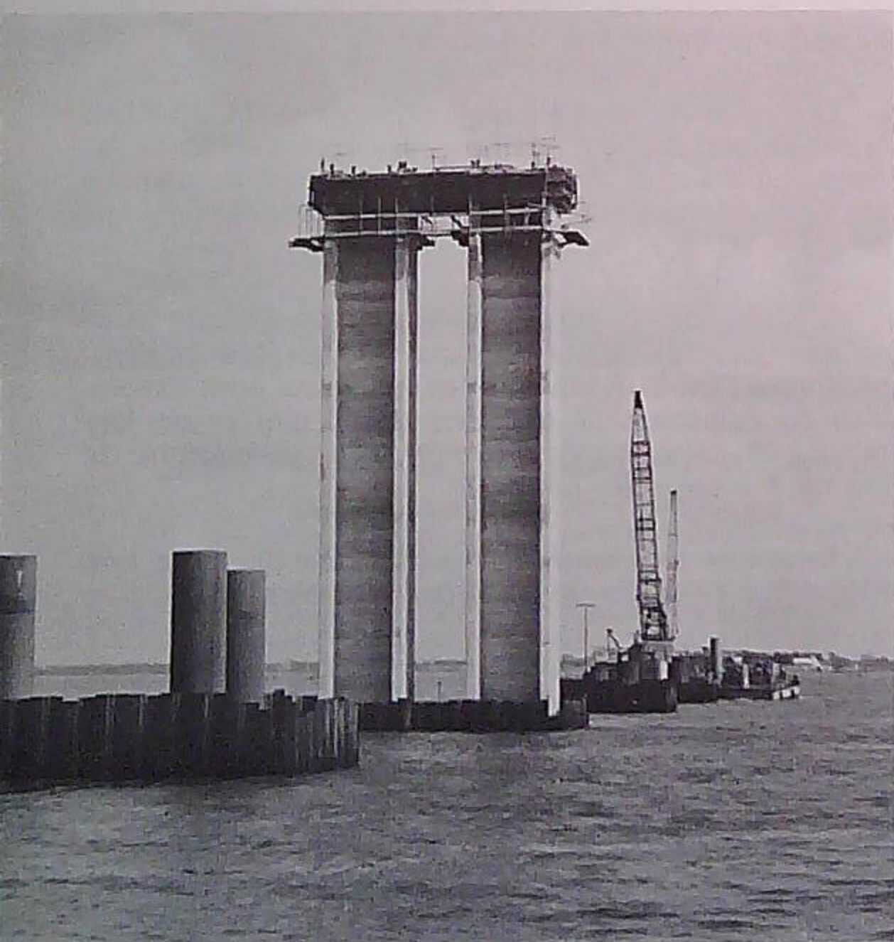
Fût de la pile n° 10 en cours de construction. On aperçoit au premier plan le batardeau en palplanches Larssen de même que 3 des 4 pieux (diamètre 1,50 m) de la pile n° 11.
