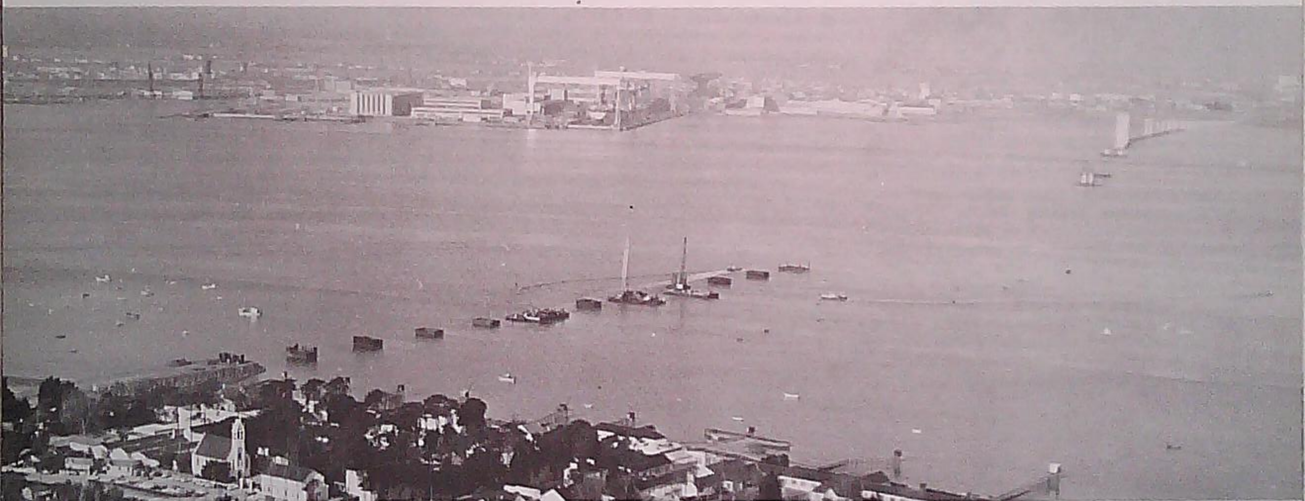
Etat des travaux (Nov. 73)
