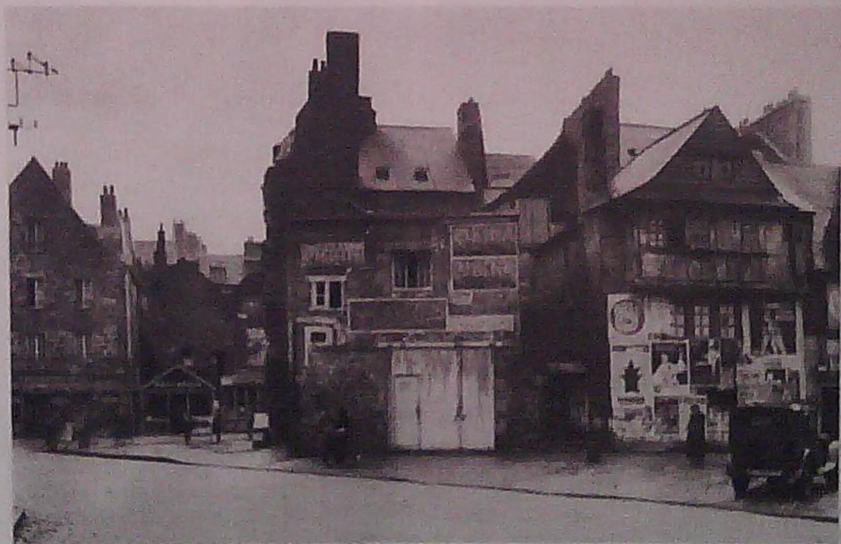
A SAINT-BRIEUC. — Rue aux Toiles : tout un coin ancien démolli récemment, à côté de la place de Gouet.
