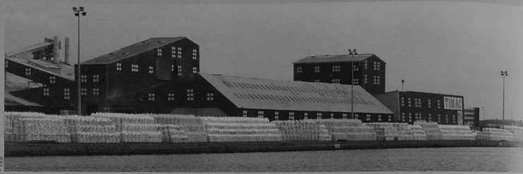
SAINT-MALO. DES STOCKS D'ENGRAIS QUI FINIRONT EN PARTIE DANS NOS RIVIÈRES.
