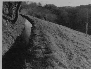
LE CANAL AU-DESSUS DES PRAIRIES PERMET D'ALIMENTER LES RIDOLES
