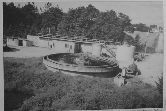
La station d'épuration à Saint-Nicolas du Pelem.
