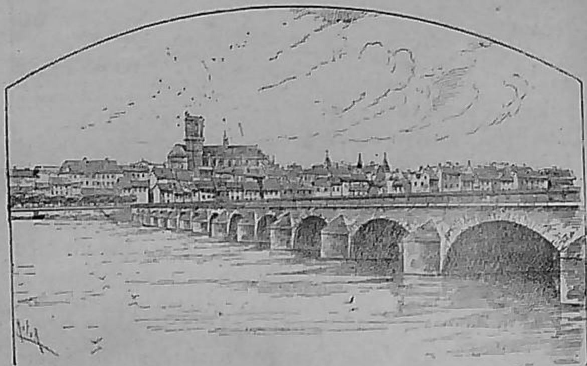
FIG. 202. — Nevers. — Le pont de la Loire — Nevers, chef de la Nièvre, au confluent de la Loire et de la Nièvre; faïenceries célèbres. Aux environs, usines métallurgiques de Fourchambault, Imphy, Guérigny (forges de la Marine).
