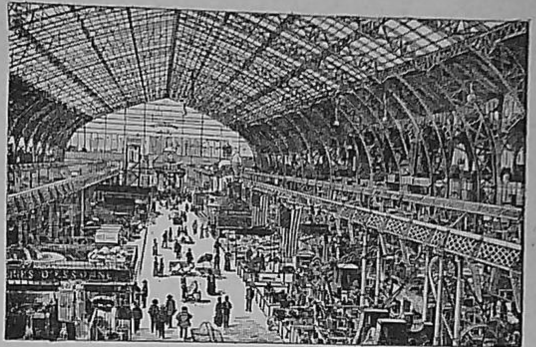
FIG. 286. — La galerie des machines. — Le palais des machines, une des merveilles de l'Exposition de 1889, est une immense construction en fer. Il a 420 mètres de longueur sur 115 de largeur; sa hauteur est de 48 mètres; il couvre une superficie de 5 hectares. Le palais des machines n'a pas été démoli après la clôture de l'Exposition.
