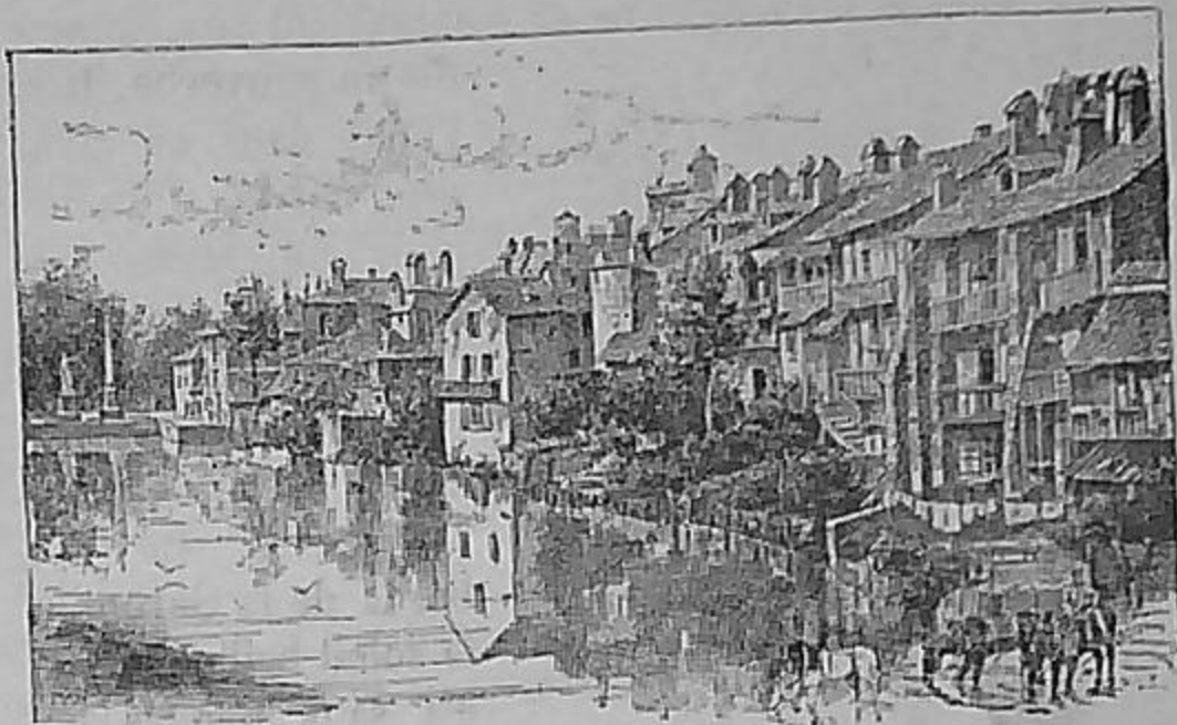
FIG. 179. — Aurillac. — Vue du canal. — Aurillac, (14 700 h.) chef-lieu du Cantal fabrique de chaudronnerie, commerce de chevaux, de bestiaux, de fromage du Cantal. — Patrie de Gerbert, qui fut pape sous le nom de Sylvestre II.
