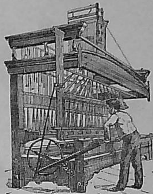
FIG. 247. — Métier Jacquard. — On emploie ce métier pour le tissage des étoffes de soie unies et brochées. La figure représente un métier à rubans qui peut tisser de 4 à 36 rubans à la fois.
