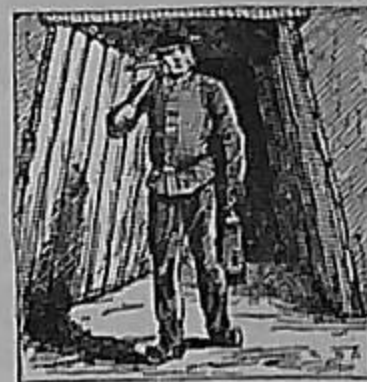
FIG. 139. — Galerie de mine boisée. — Les parois et le plafond de la galerie sont soutenus par des pièces de bois qui ont pour but d'empêcher les éboulements.
