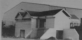
La maison des sports du Park Nevez est pratiquement terminée. Sa livraison devrait intervenir fin février.
