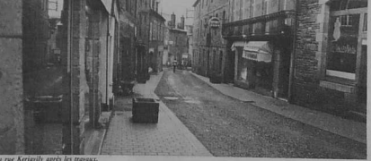
La rue Kerlaviy après les travaux.
