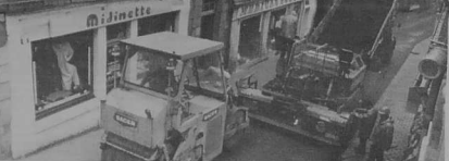
La rue Kerlaviy pendant les travaux.
