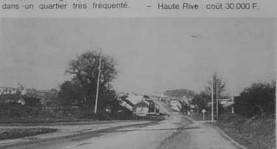
Préparation de l'éclairage public de Kerligonan jusqu'au carrefour de Servel. Le ruisseau du Rou-dour va disparaître
