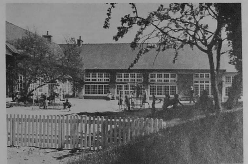
- Une école qui mérite d'être vue de l'intérieur : l'école maternelle J. Savidan après rénovation
