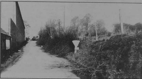
Rue Madeleine avant les travaux : une voie étroite près d'une grande surface.
