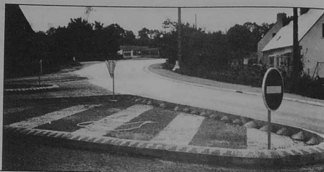
Carrefour et avenue de Park Nevez : le carrefour a été aménagé et des bordures de trottoirs posées sur la droite.
